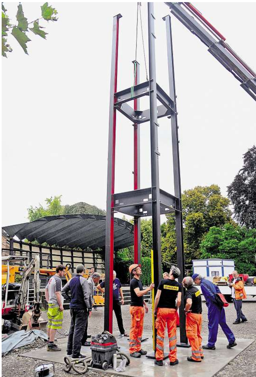
Ein Kran bringt das Grundgerüst des «Stadtspielwerks» auf den Merkurplatz.
